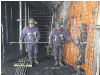
(b) “框架+预应力对拉锚杆”复合加固结构施工
