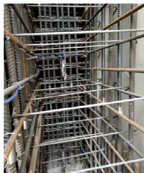
图4 预埋温度传感器试验图
